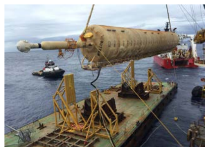
Il modulo di galleggiamento viene sollevato
