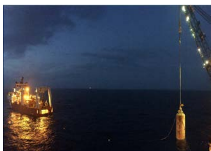
Modulo di galleggiamento in posizione verticale
