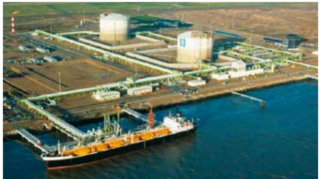
Montoir LNG Tanks in France for Gaz de France (1981)
